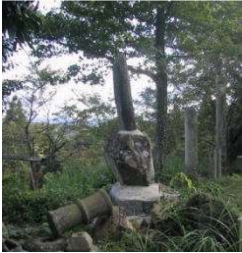
倉吉・番田稲荷神社の倒れた灯籠と傾いた石碑(左)、ずれた狛犬の台座(右)
