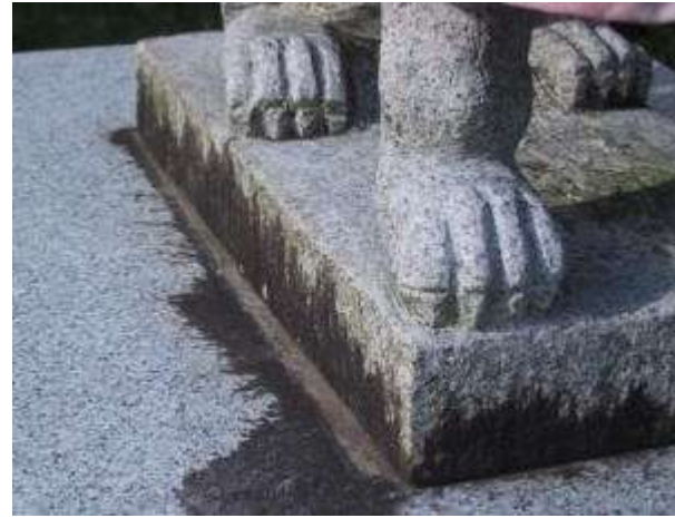
倉吉・番田稲荷神社の倒れた灯籠と傾いた石碑(左)、ずれた狛犬の台座(右)
